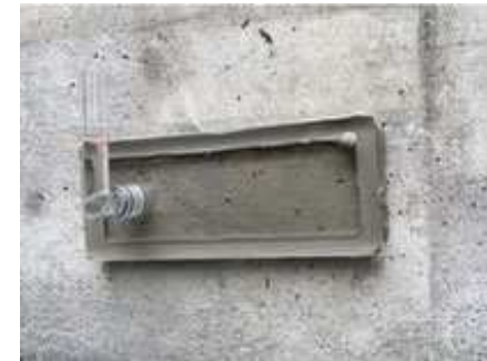
Näherungsweise Messung am Objekt
